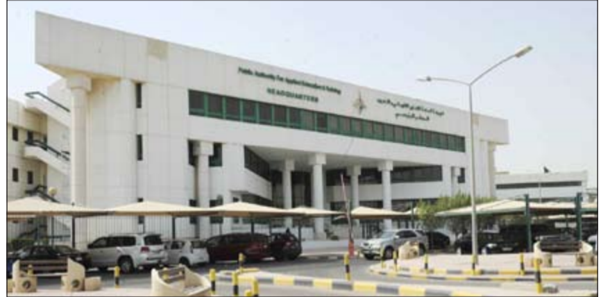
مبنى الهيئة العامة للتعليم التطبيقي والتدريب
